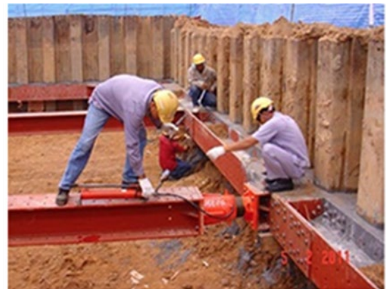
รูปการติดตั้งเหล็กค้ำยัน (Strut) และ Kirin Jack
